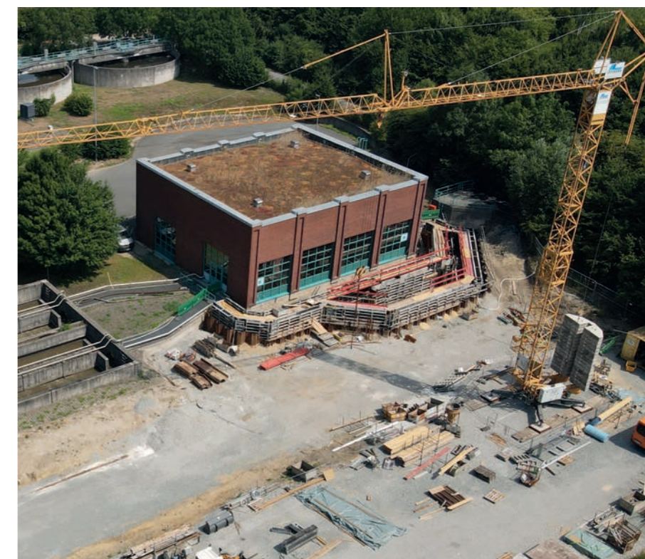
Neubau Rechenanlage und Umgehungsgerinne Kläranlage Hamm-West
